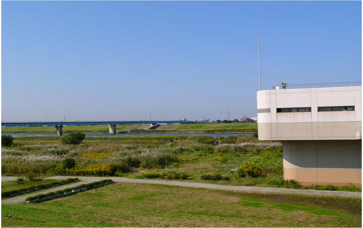
處理設施操作塔及處理場址地面狀況(2.4-2)
