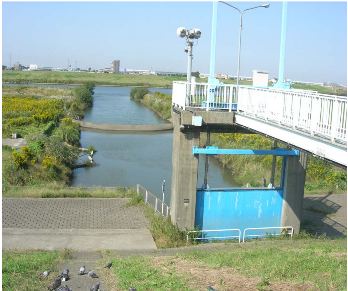
污水進流幹排及取水橡皮壩(2.4-1)
