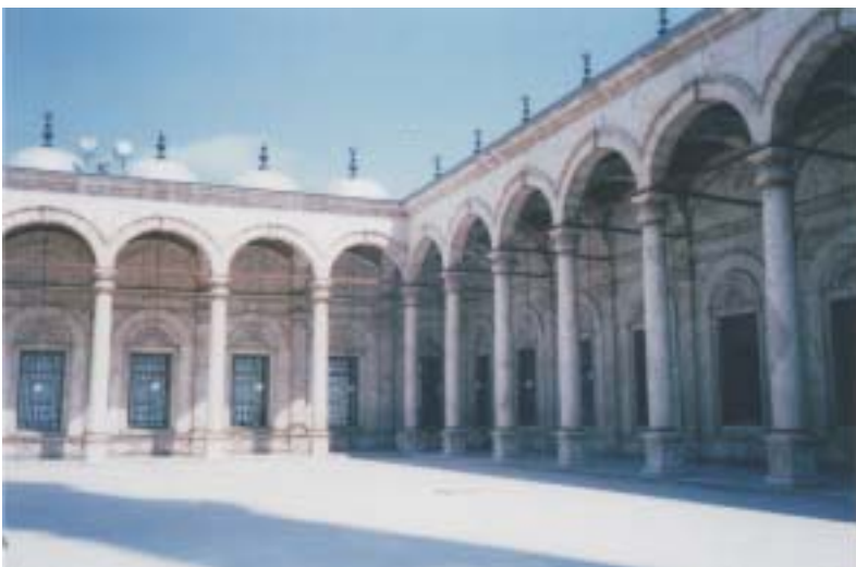
◎木柱廊上加固之鐵架清晰可見
