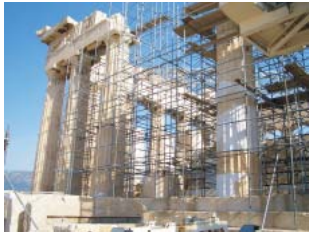
◎ 巴特農神廟北面柱子整修情況
