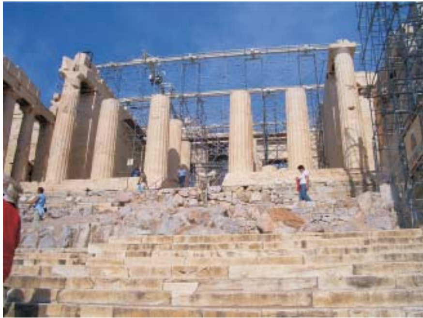
◎ 中央樓東面大門六支多立克式柱
