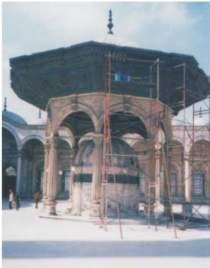
◎ 水池上之小亭正維護上漆中
