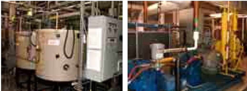
消毒淋浴系統，係提供 BSL-4 實驗室操作人員離開實驗室時，藉經由 5 分鐘 Micro-Chem Plus 消毒液之化學淋浴方式，清消人員穿著之正壓供氣式連身氣密防護衣之用。一如其他用於 BSL-4 實驗室之生命安全維持系統，消毒淋浴系統亦以重複配置方式，建立備份系統，包含 Micro-Chem Plus 原液抽取管路與馬達、稀釋至 5% 之消毒液儲存槽與導電度監視系統，以及壓縮儲存槽等(如上圖)。
