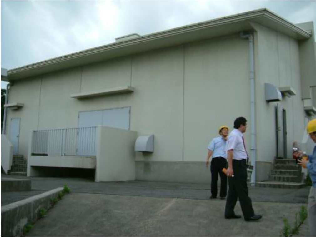
圖 4-22 通風風機室及豎井維修進出口外觀圖
