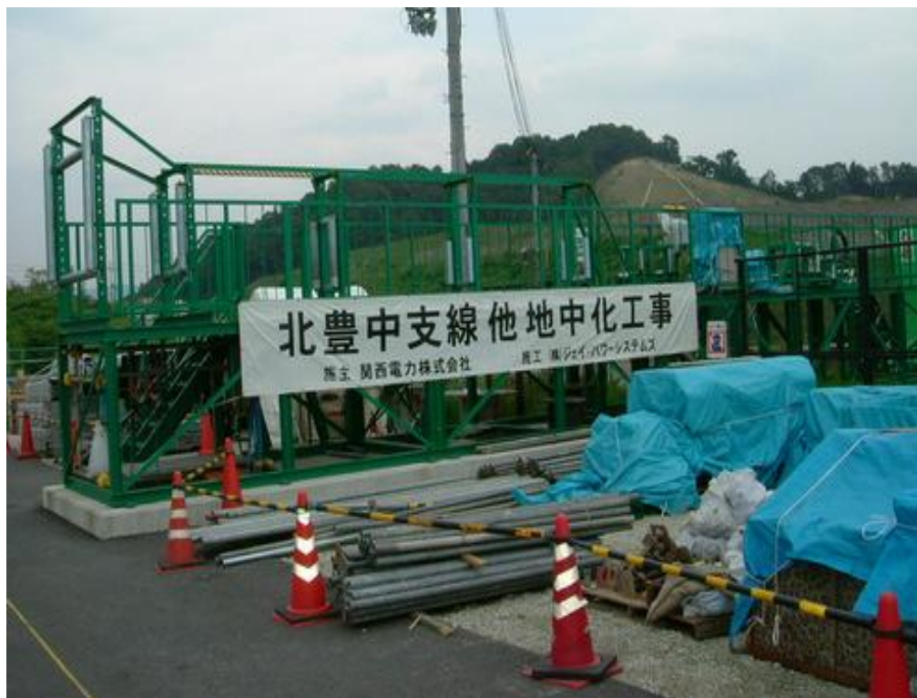
圖 3-15 電纜延放平台
