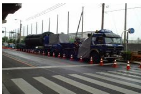
圖 3-4 長尺電纜施工例
