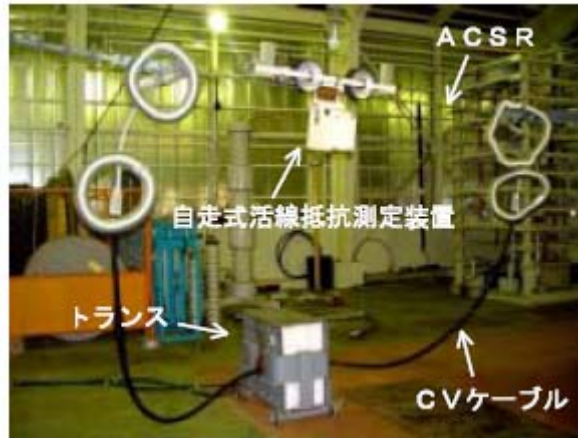
相片8：耐壓試驗狀況
