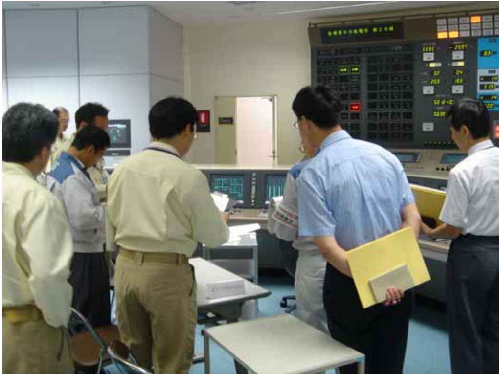
測試完畢後檢查人員與測試人員確認測試結果情形
