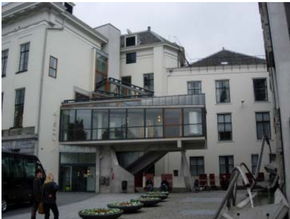
烏特列支市政廳外觀(新舊共存建築案例)
