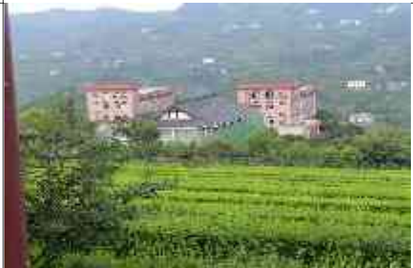
俯瞰服務中心及施工中之仰光仙逸樓
