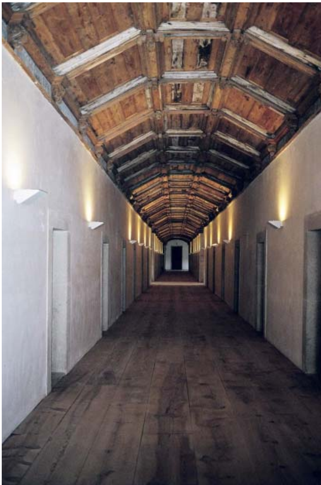
整修前的修道院
