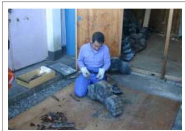
冰川神社修復師傅施工現況
