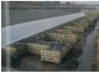
木工床施工狀況
