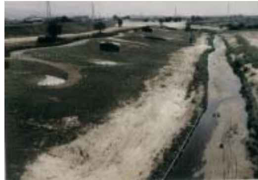
圖 3-24 高橋緩坡護岸
