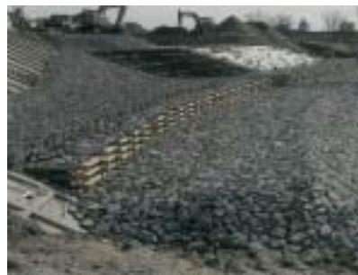
木工沉床及柳枝工施工狀況
