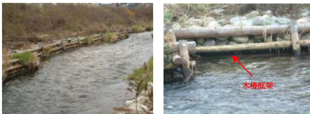
圖 3-34 木樁框架卵石低水護岸
