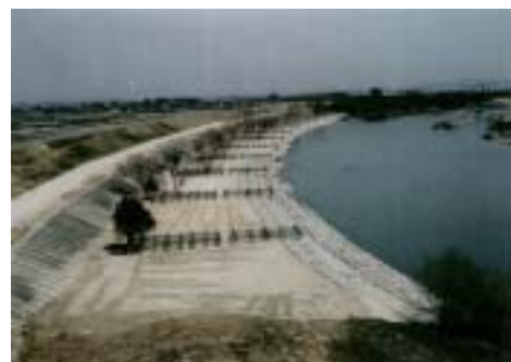
圖 3-16：框架式丁壩竣工時全景
