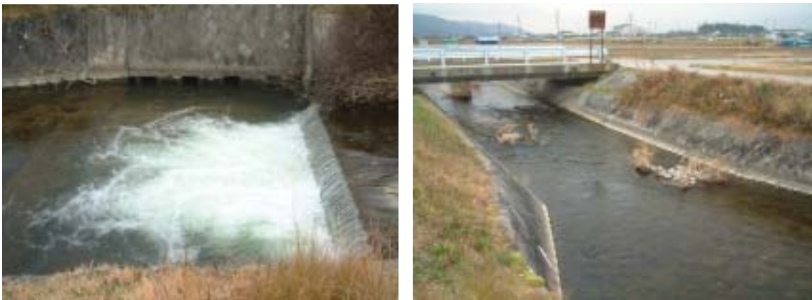
圖3-36 混凝土塊護岸
