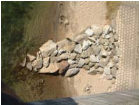
橋樑下游左岸丁壩
