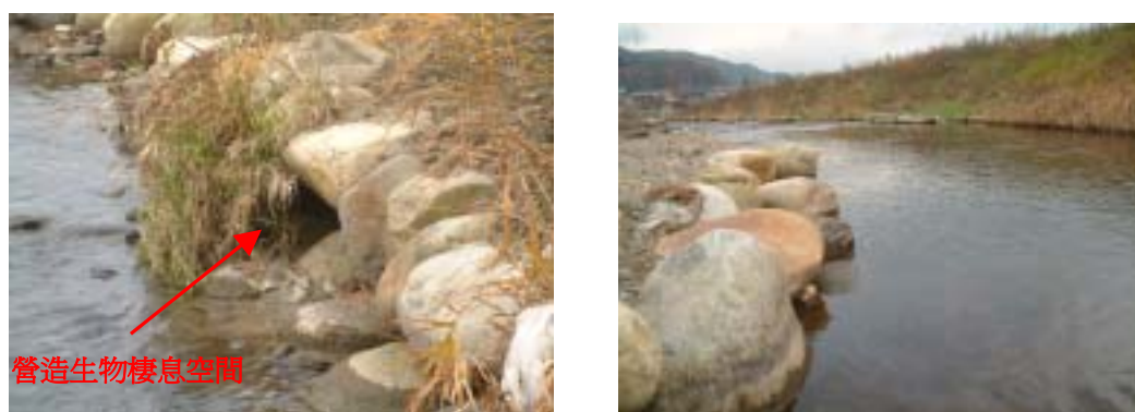
圖 3-33 砌石低水護岸
