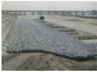
鋪石施工狀況
