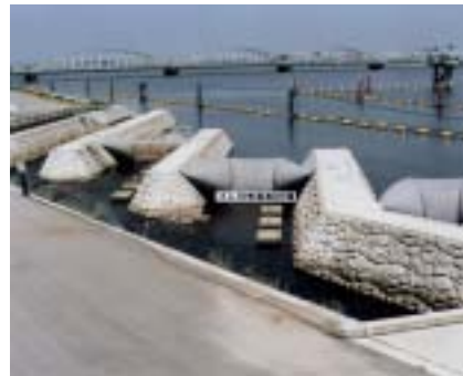
圖 3-9：淺灘式魚道上游端橡皮壩
