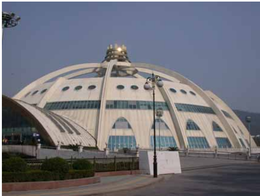
照片十一、南京太陽宮廣場(四支拱梁為輕質混凝土澆製)
