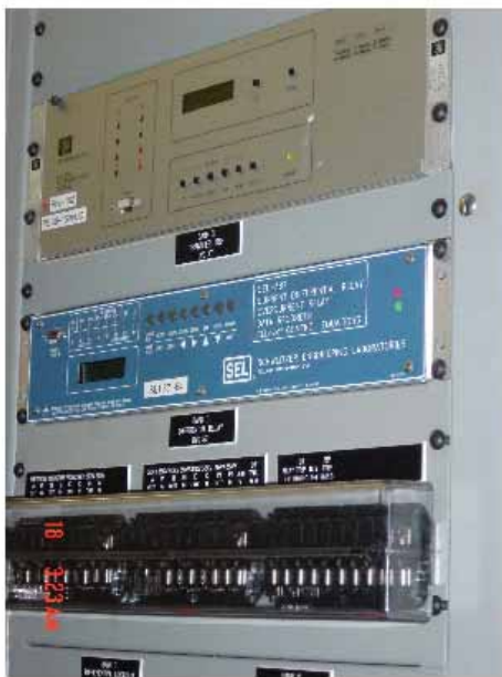
圖 4-2 數位式電驛盤面
