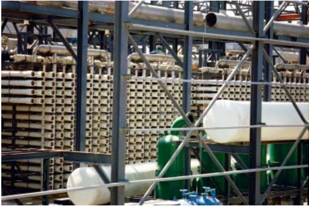
埃墟克隆(Ashkelon)海水淡化廠雄偉的逆滲透處理系統
