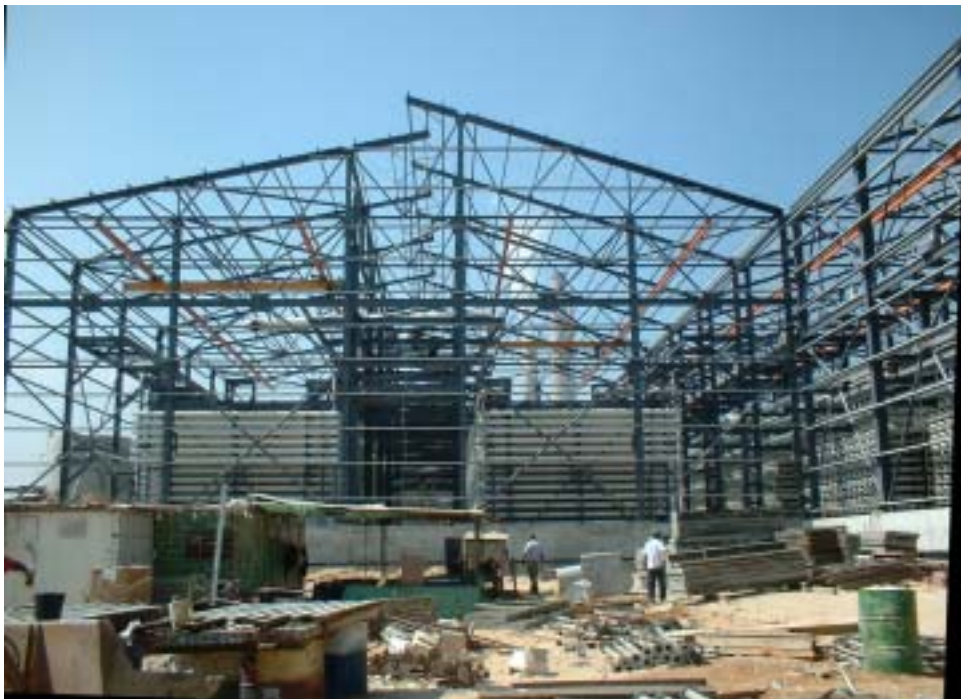
該廠被設計為兩座幾乎可完全獨立操作的分廠參訪時廠房鋼構已組立完成
