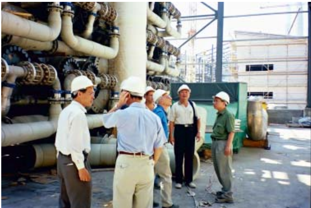
埃墟克隆(Ashkelon)海水淡化廠相關節能設施規劃非常細心 電力需求--埃墟克隆發電廠
