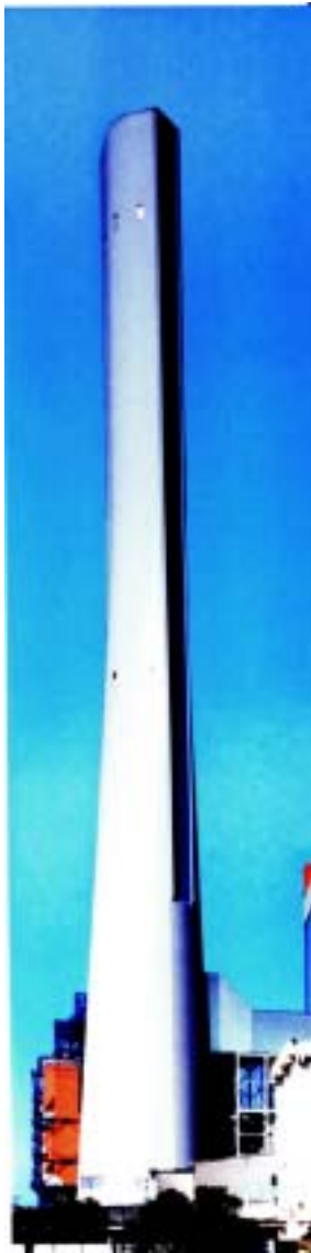
圖 8 磯子發電廠 200M 高之 混凝土煙囪 (93/1124, #93N1573_1279)
