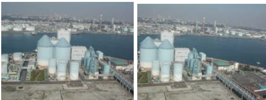
圖 7 磯子發電廠密閉式煤倉及真空輸煤帶
