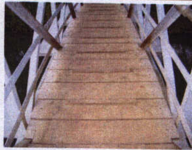
較陡之橋面則有防滑處理。
