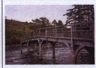
The Thames Path 跨河木橋。
