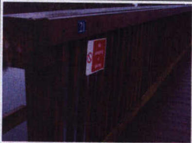
The Thames Path 有遊客安全之虞路段設置之警告標誌。
