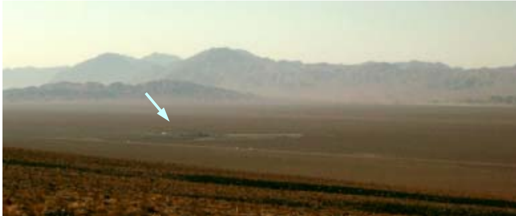
圖 5-4 位於西南方沙漠地帶的低放處置場
