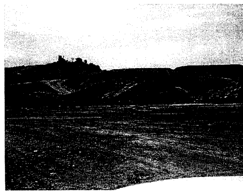
圖 14-5、使用焚化灰渣當覆土材料
