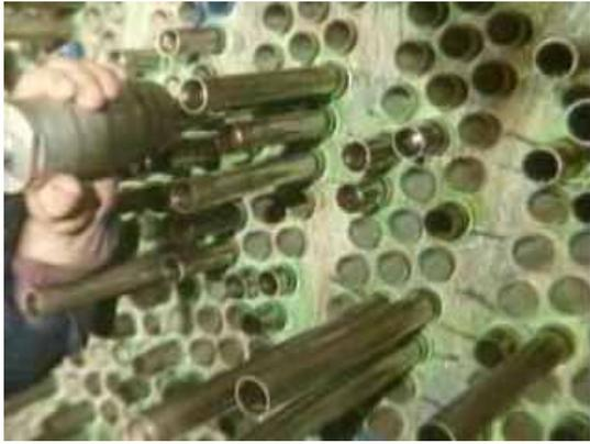
圖7. 缺陷管局部Sleeve
