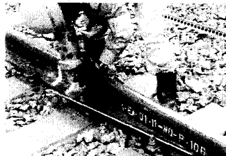
レール溶接部削正
