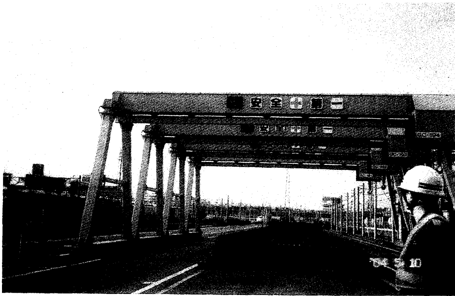
圖貳-三-04 大井維修基地門型吊車
