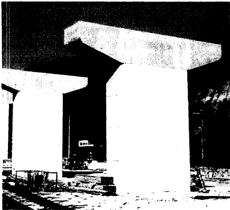
西神道路柏木谷高架橋への適用
