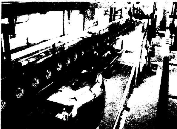
12月18日：法國 La Plagne 滑雪勝地中之複式單線 (DMC) 自動循環式空中纜車系統 (站內驅動單元)
