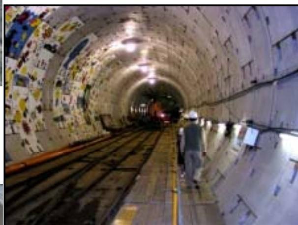
圖五十四、七公尺直徑取水管溝
