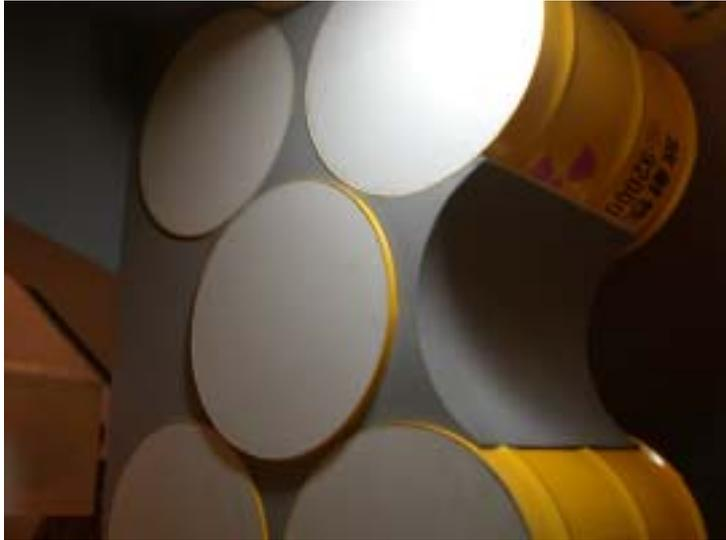
◀圖十一、低放桶間砂漿填充後
