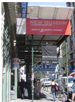
正在整修門面的新美術館
