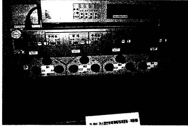
圖肆-2 KEPCO 自動化用開關之控制箱
