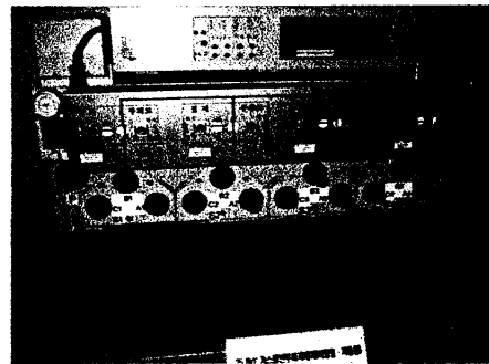
圖肆-7 地下自動開關
