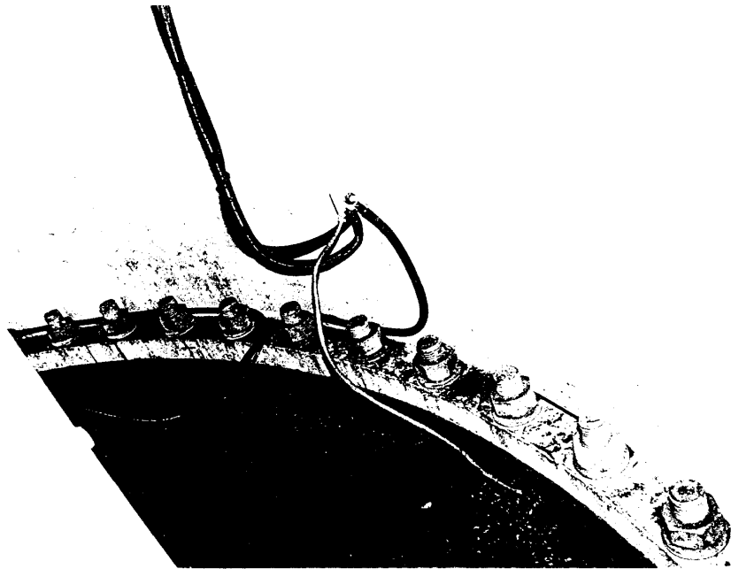
圖 13 避雷線（接地電阻限制於 2\Omega 內）
