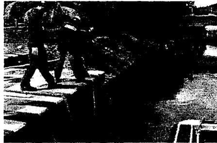
4.一端固定在鋼纜之聯接器,另一端以小艇布放攔油索圍繞停泊船,並將兩端固定。
