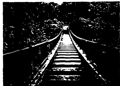
写真2-5-5 くずはのつり橋
