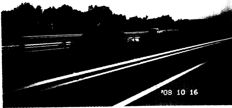
突尼斯高速公路中央分隔帶及護欄
