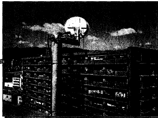
NTTビル屋上に設置されたAPとサービス対象のマンション
