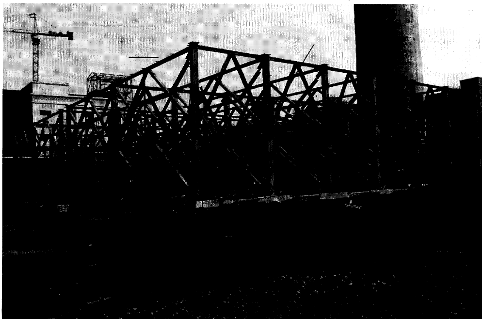
二十一、靜電集塵器支持結構的施工情形：
