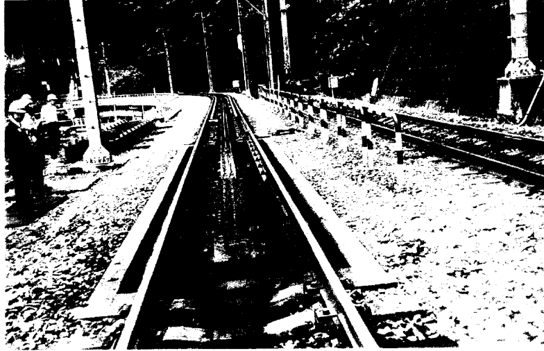
附錄相片27：電機車進入齒軌前經過調整台
