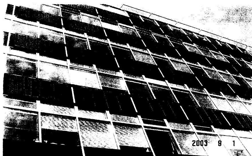
大樓外牆太陽能板應用實例
