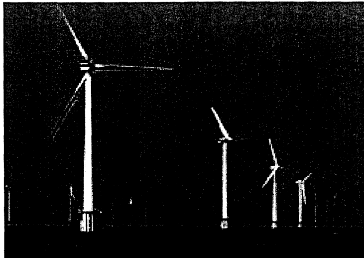
圖 2-9 離岸風力發電機之實照圖
