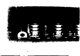
異常位置 變壓器 原因 引接頭 鎖接不良
