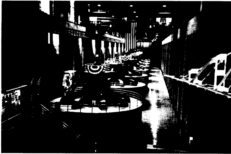
照片 3-8 胡佛發電廠發電機組
