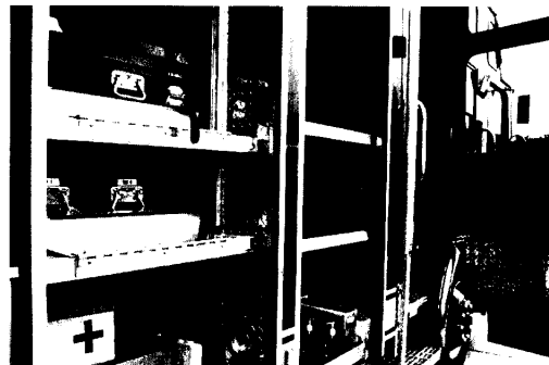
危險物品處理車內部裝備
