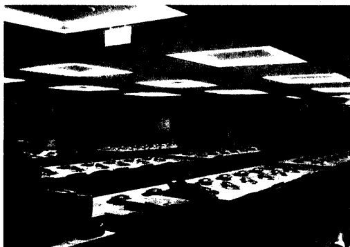
通訊室內部配置概況
