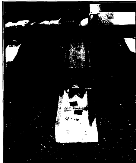
照片 3.2-25 常盤新線調車場(六) 異型枕木，兩側之溝 槽係供機電管線穿 過，將來會加蓋
