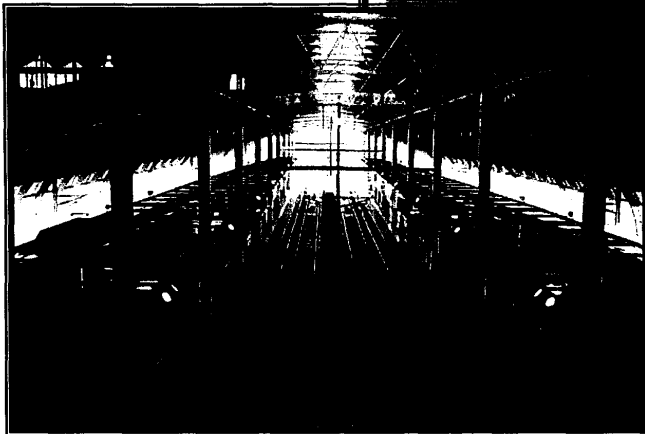
照片 3.1-6 新幹線八戶站月 台、軌道、電車 線等設施，八戶 站內軌道係採道 碴軌道鋪設
