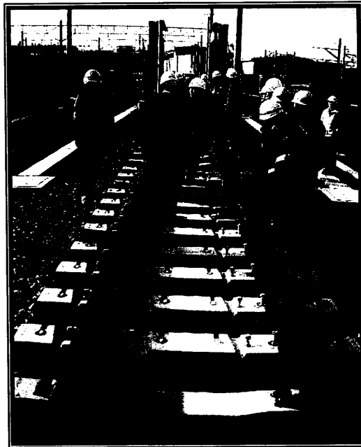
照片 3.2-21 常盤新線調車場(二) 平交道版下方之枕木 型式及固定平交道版 之螺栓
