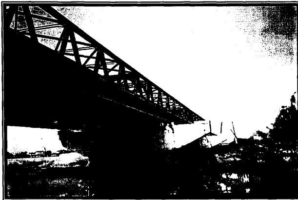
照片 3.2-5 常磐新線跨河橋 中間為鐵路橋 Warren Truss 兩 旁為公路橋（鋼 箱型梁橋，拍攝 側尚未吊裝，另 一側已吊裝）
