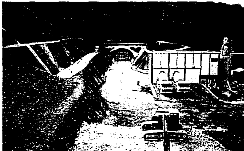
隧道起點坑口
