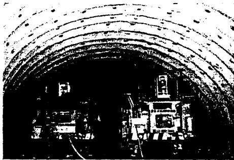
写真-1 本坑上半削孔作業
