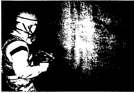
写真-7 断熱材の吹付け作業
