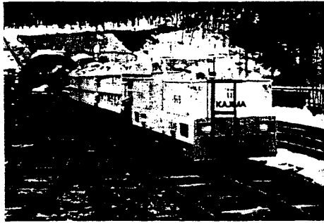
写真-6 ずりトロッコで平湯側へ運搬
