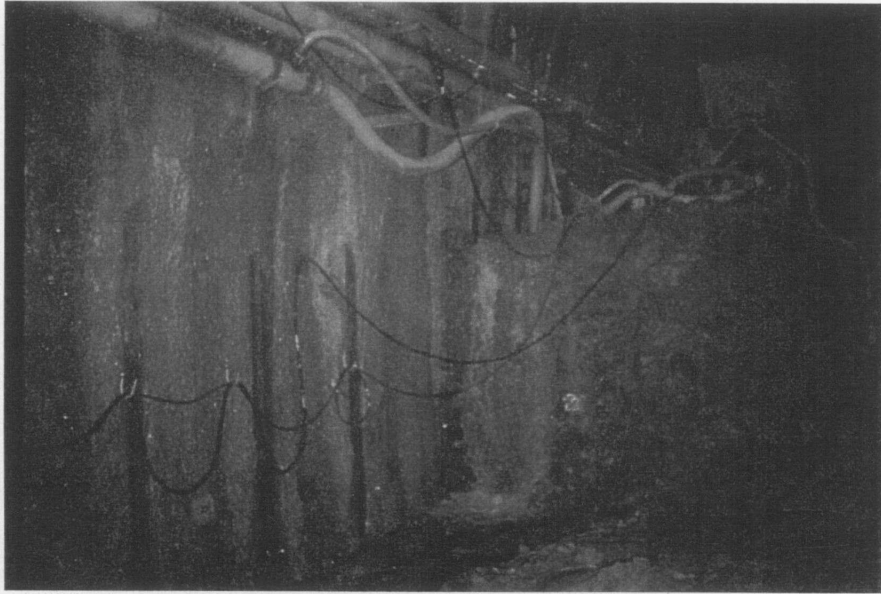
相片三 水平鑽孔排水情形
