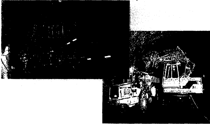
大型マシンによるトンネル掘削 (五里ヶ峰トンネル)
