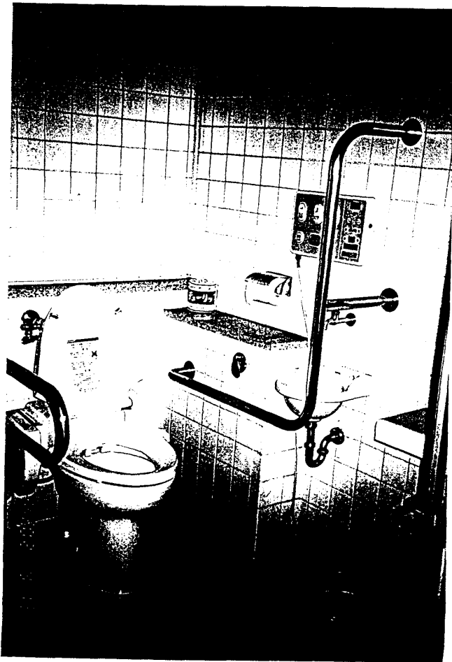
註：浴室內之輔具裝設
