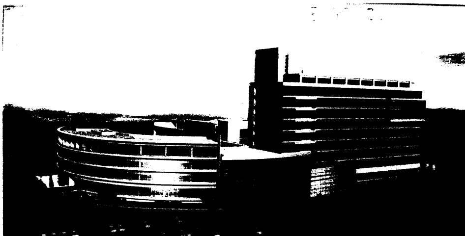
興建中的安森科技園區大樓全景
