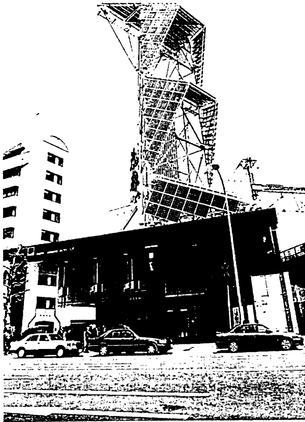
圖 2-5 Eco 加油站防災型太陽光發電系統
