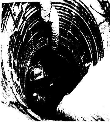
1. 孔內掘削狀況(機械掘) 軀體徑2.5m
