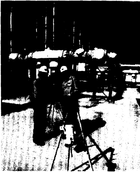
數位攝影系統安裝中
