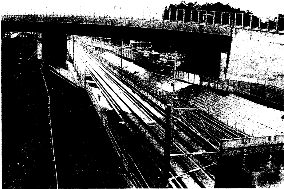
東北新幹線，盛岡~八戸間/瀧沢隧道附近坡面工
