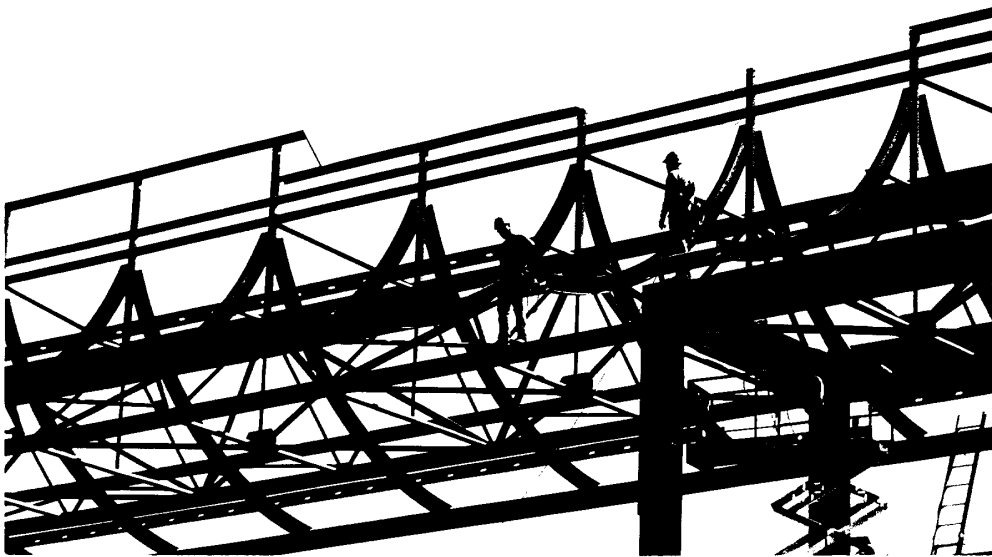
圖 10 從事鋼構組立作業人員穿戴全身式之安全帶
