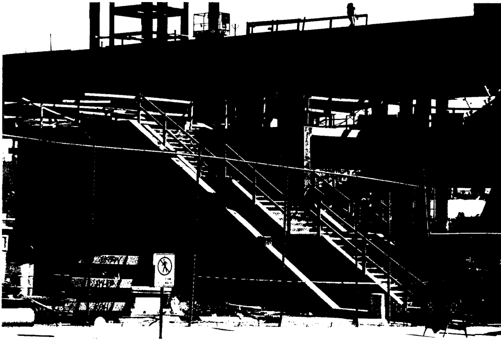
圖 9 工地現場樓梯、開口等護欄之設置情形
