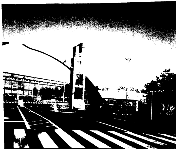
▲照片 3-3 高陽機廠廠處
