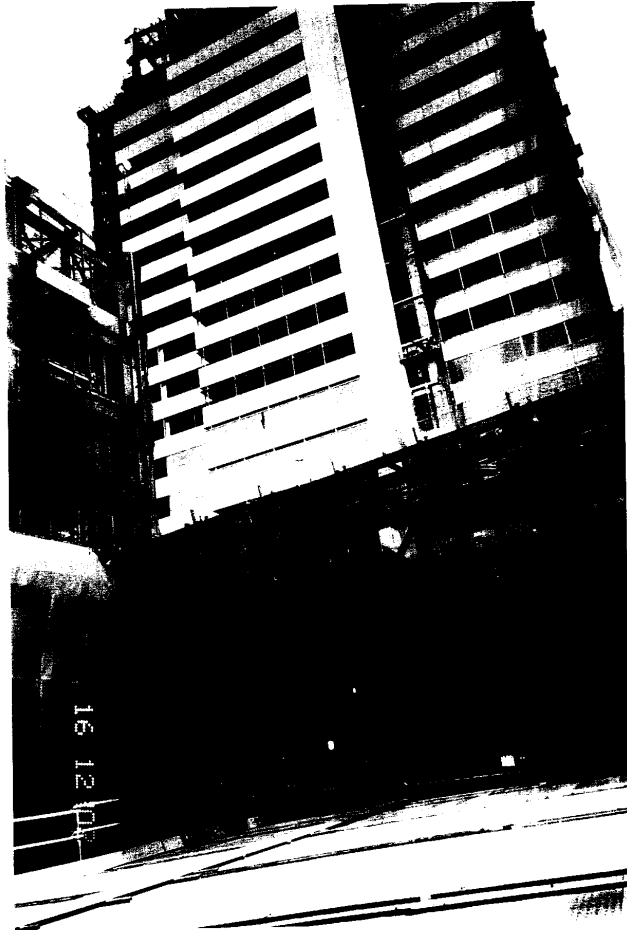
照片5-11 品川新站工地現場與開發基地
