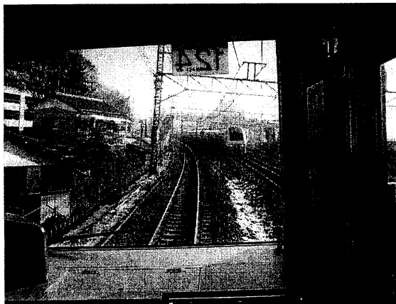
照片 5.4-3 東京都 JR 常盤線 軌道
