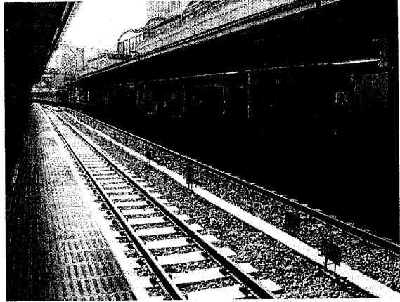
照片 5.4-2 東京都 JR 山手線軌道
