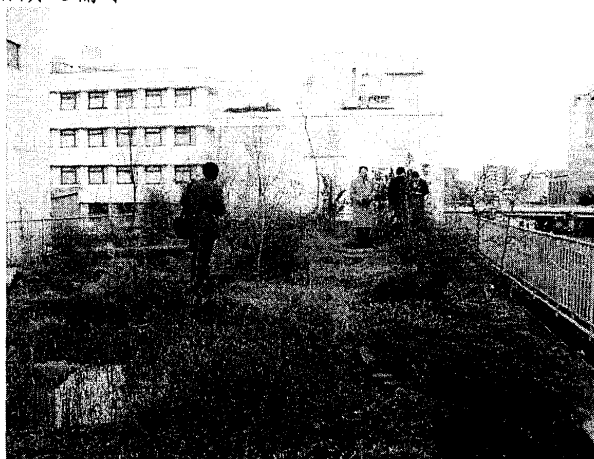
照片 4.3-5 屋頂的自然生態保護區
