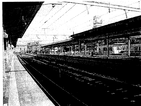
照片 5.4-4 東京都 JR 常盤線軌道
