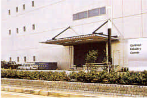
Truck yard 車両出入口並びに積み降ろし用ランプ
