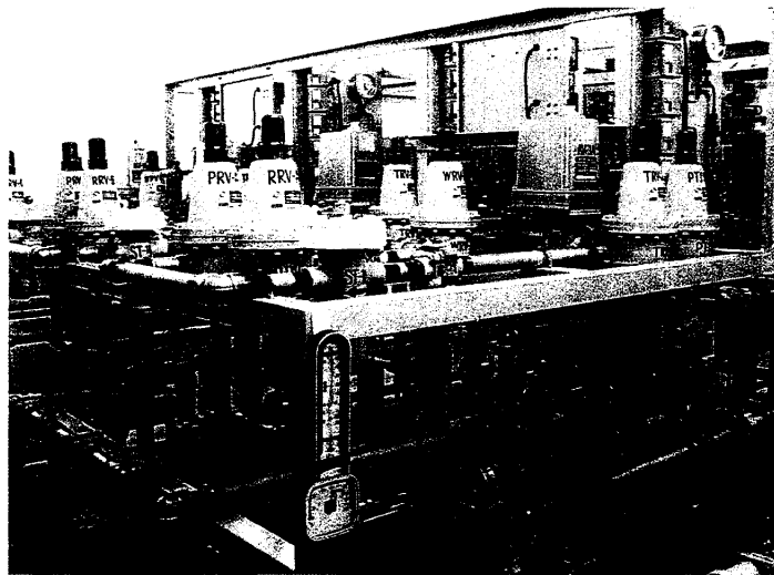
圖 6.27 海底電纜線路補油泵浦外觀圖
