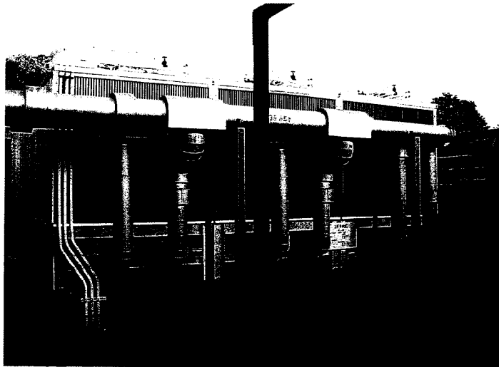
圖 4.3 密閉式冷卻水塔
