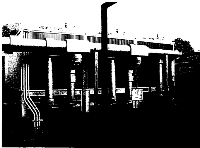
圖 6.15 密閉式冷卻水塔外觀圖
