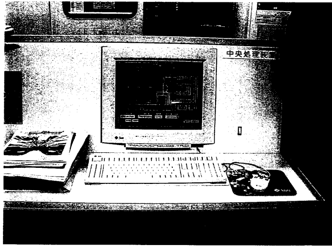
圖 6.18 洞道內及冷卻機房冷卻系統電腦監控系統
