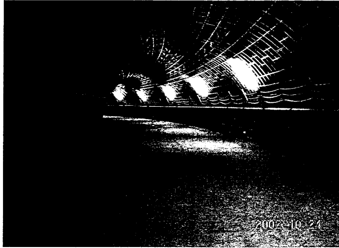
圖 6.5 潛盾洞道使鋼環片用外觀圖
