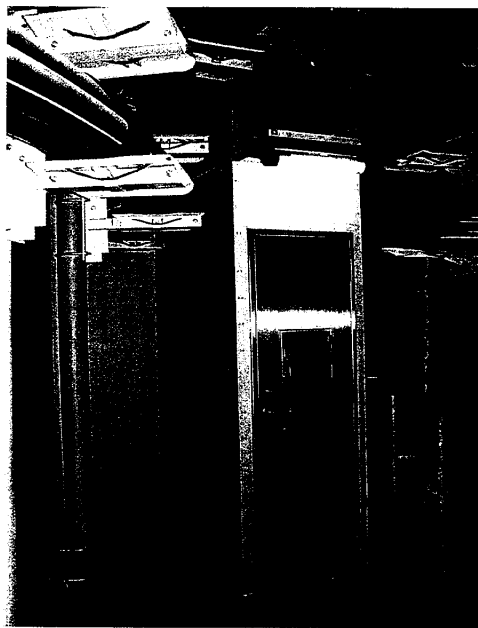
圖 6.21 洞道內通風區段分隔用之閘門(二)
